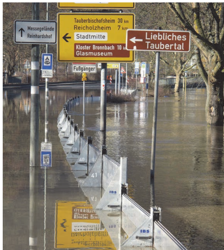
3 | Entlang der Maintalstraße errichtete Spundwände sind Teil der Hochwasserschutzmaßnahmen der Stadt Wertheim. Aber auch sie bieten bei steigenden Pegeln nur zeitlich befristet Schutz. Aufnahme: privat.
