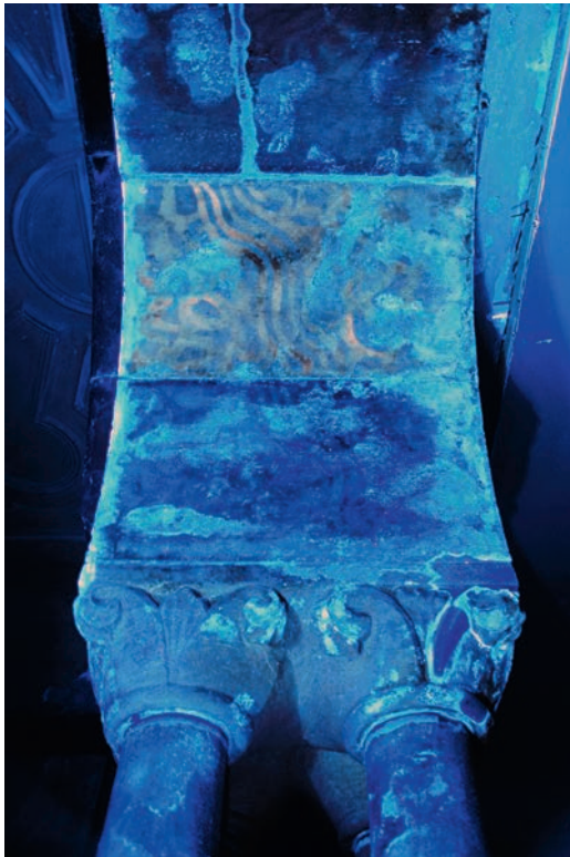
Abb. 10: UV-Aufnahme des östlichen Bogens der Nordarkade mit einem Segment ehemals farbiger Marmorierungen (Foto: Elke Umminger-Gundacker)
