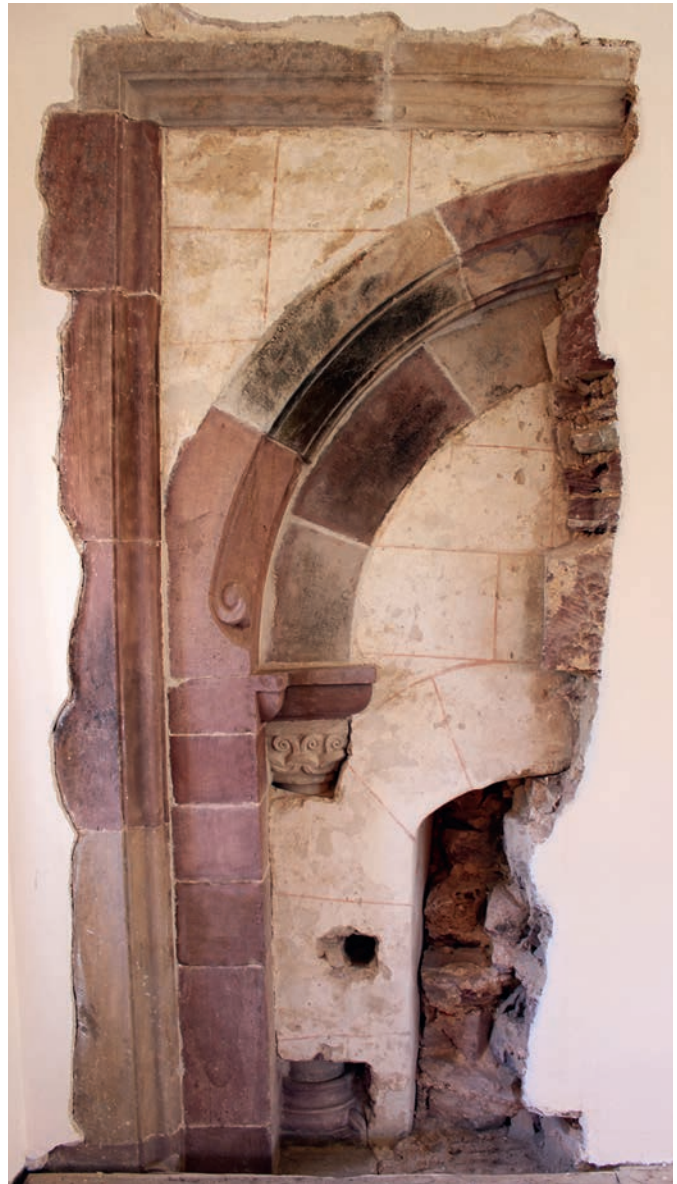
Abb. 5: Südliche Hälfte des südlichen Doppelbogens der Talseite, 1. Bauzeit. Fenster niche und Quaderfugennetz, 2. Bauzeit (Foto: Goswin v. Mallinckrodt)
