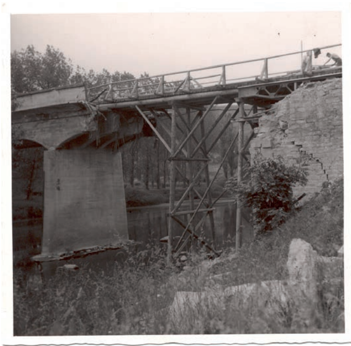
Abb. 5: Neckarbrücke bei Besigheim (StAL EL 75 VI DO 40).
