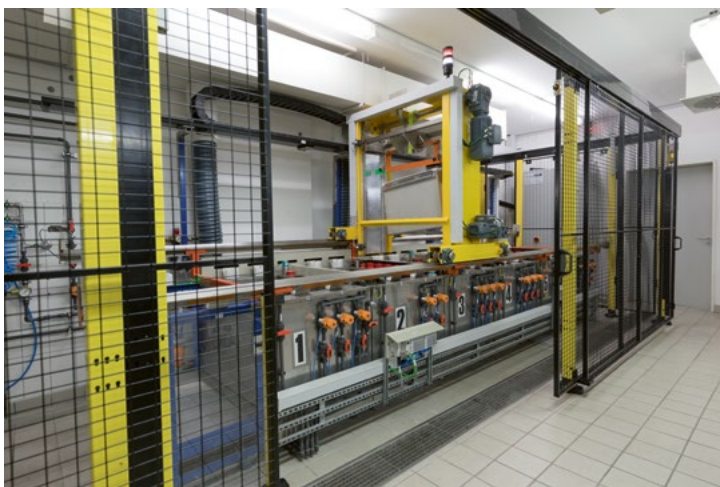
1 Tauchbeckenanlage bei aufgeschobenem Schutzgitter, in der Bildmitte der Transportwagen mit Siebkassette.
